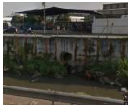
Figura 28.24 – Saída da tubulação existente no Rio Tamanduateí
