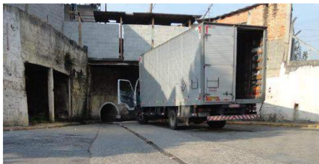
Figura 28.23 – Tubulação existente acima do nível da via.
