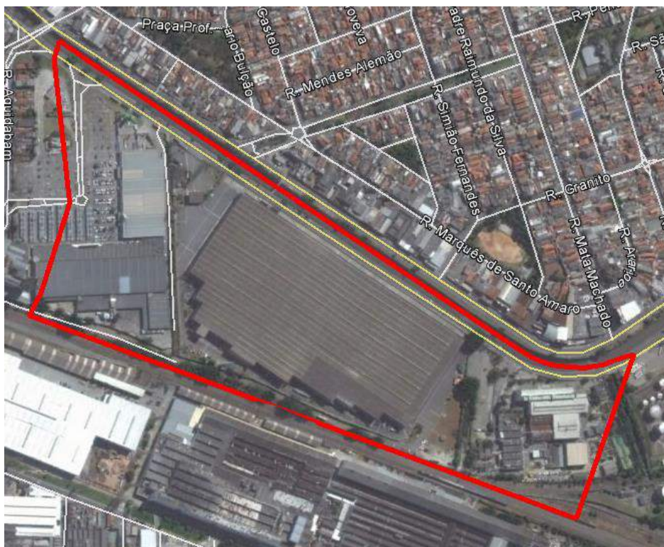
Figura 21.3 – Localização da sub-bacia B1
