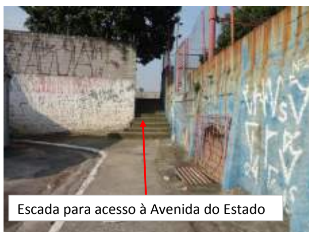
Figura 28.22 – Rua da Fortuna encontra-se abaixo do nível da Avenida dos Estados
