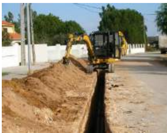
Figura 29.1 – Ilustração de escavação mecânica
