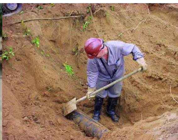
Figura 29.2 – Ilustração de escavação manual
